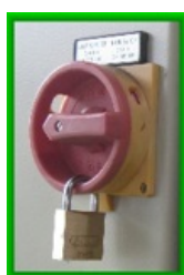
Afbeelding: vergrendelde hoofdschakelaar
