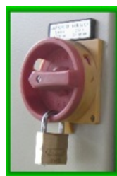
Afbeelding: vergrendelde hoofdschakelaar
