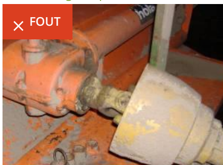
Afscherming niet compleet, kap ontbreekt
