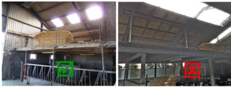
Foto Zolder met afscherming en open zolder
