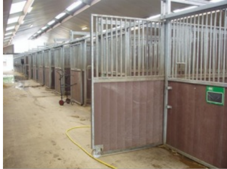
Uitschuifbare tussenwand, hier nog niet volledig uitgetrokken
